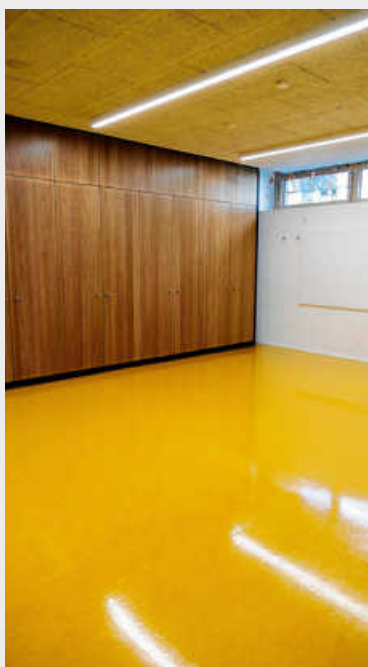
Der neu versiegelte Boden erstrahlt nach der Grundreinigung wieder in neuem Glanz.
