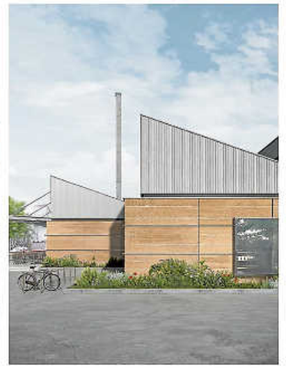
Visualisierung der Sheddachhalle: links der heutige Bestand, rechts die geplante Gestaltung nach der Revitalisierung mit einer Fassade aus natürlichem Stampflehm.
