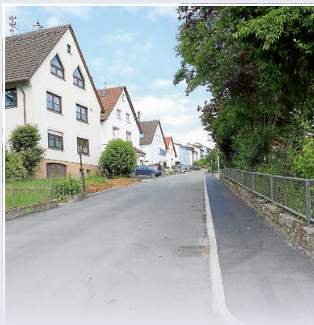
Mit dem neuen Straßenbelag ist die Sanierung des Nußbaumwegs nun abgeschlossen.
