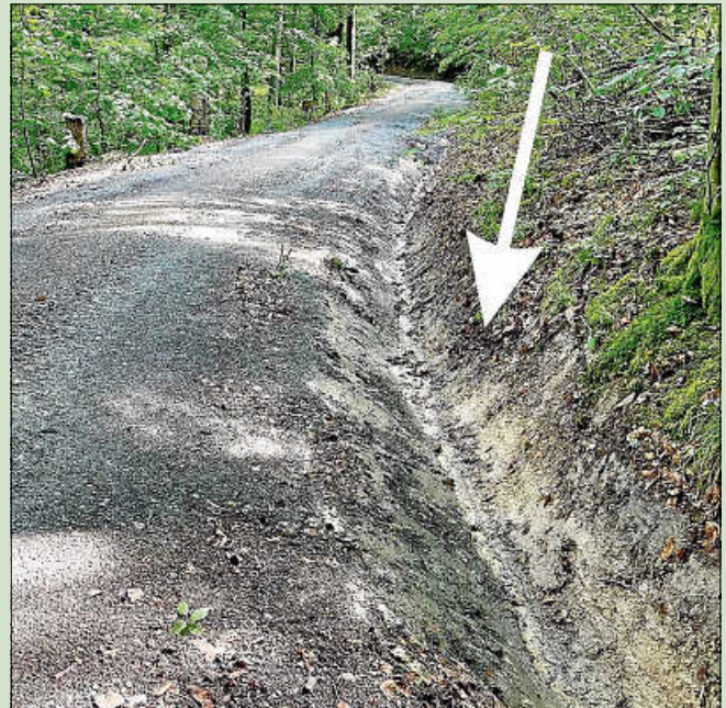
Das uhrglasförmige Profil leitet das Wasser in den Graben
