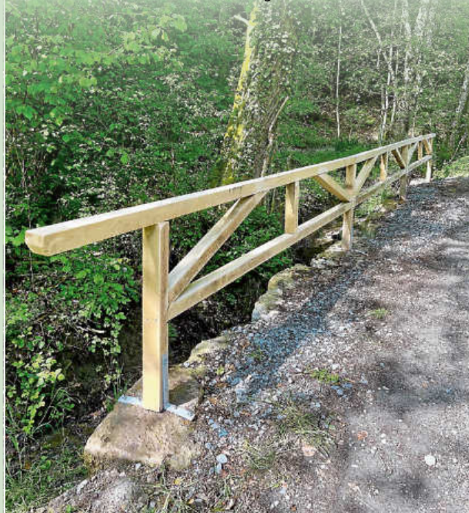
Das neue Brückengeländer am Buchtraufweg
