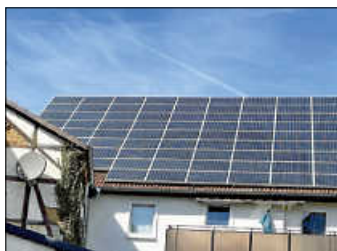
Dach eines Privatgebäudes, auf dem engmaschig Solarmodule angebracht wurden. Foto: LEA
