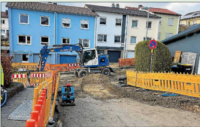
Endspurt: Asphaltarbeiten im Nußbaumweg
