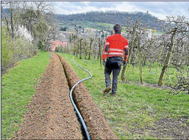
Arbeiten an der Wasserleitung zum Petersbergfriedhof
