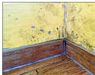
Die Ecken von Räumen sind klassische Wärmebrücken, an denen sich häufig Schimmel bildet.
