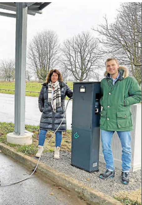
Neue E-Ladestationen im Mineralfreibad Oberes Bottwartal
