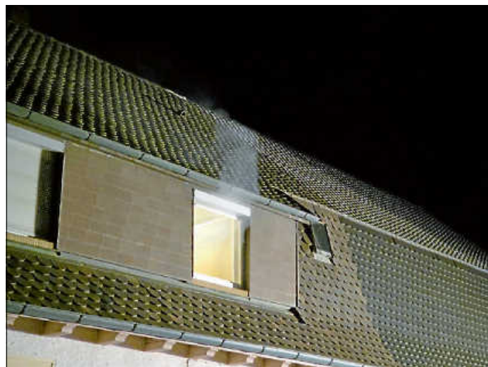
Fotos: Feuerwehr Oberstenfeld
