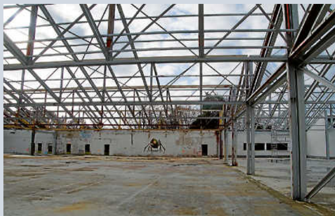
Aktueller Zustand der Sheddachhalle, die zukünftig ressourcenschonend zur Markthalle umgebaut wird.
