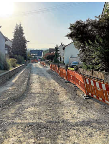
Blick auf die aktuelle Baustelle im Nußbaumweg
