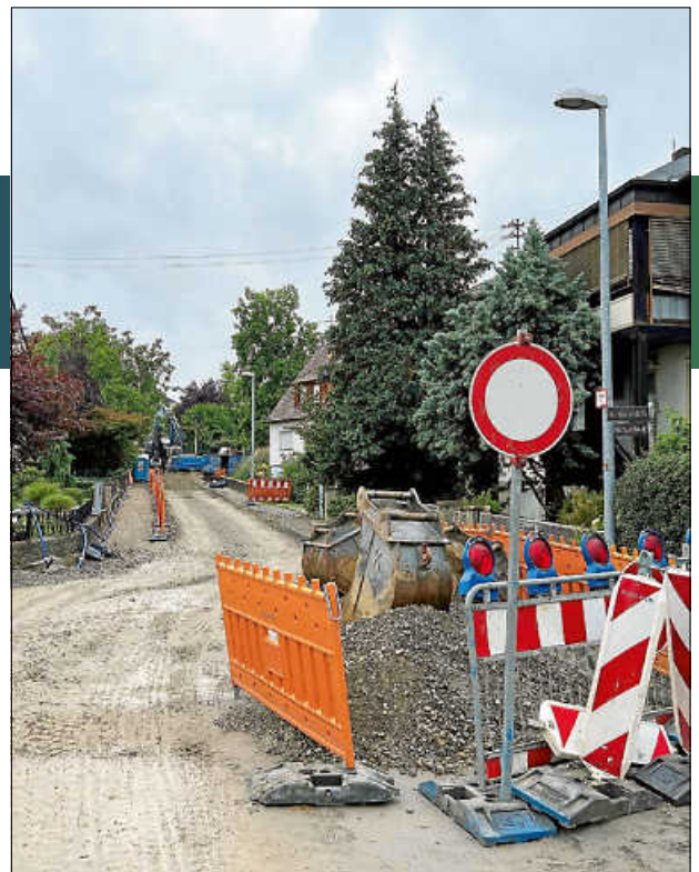
Blick auf den aktuellen Baufortschritt im Nußbaumweg Foto: Gemeinde Oberstenfeld
